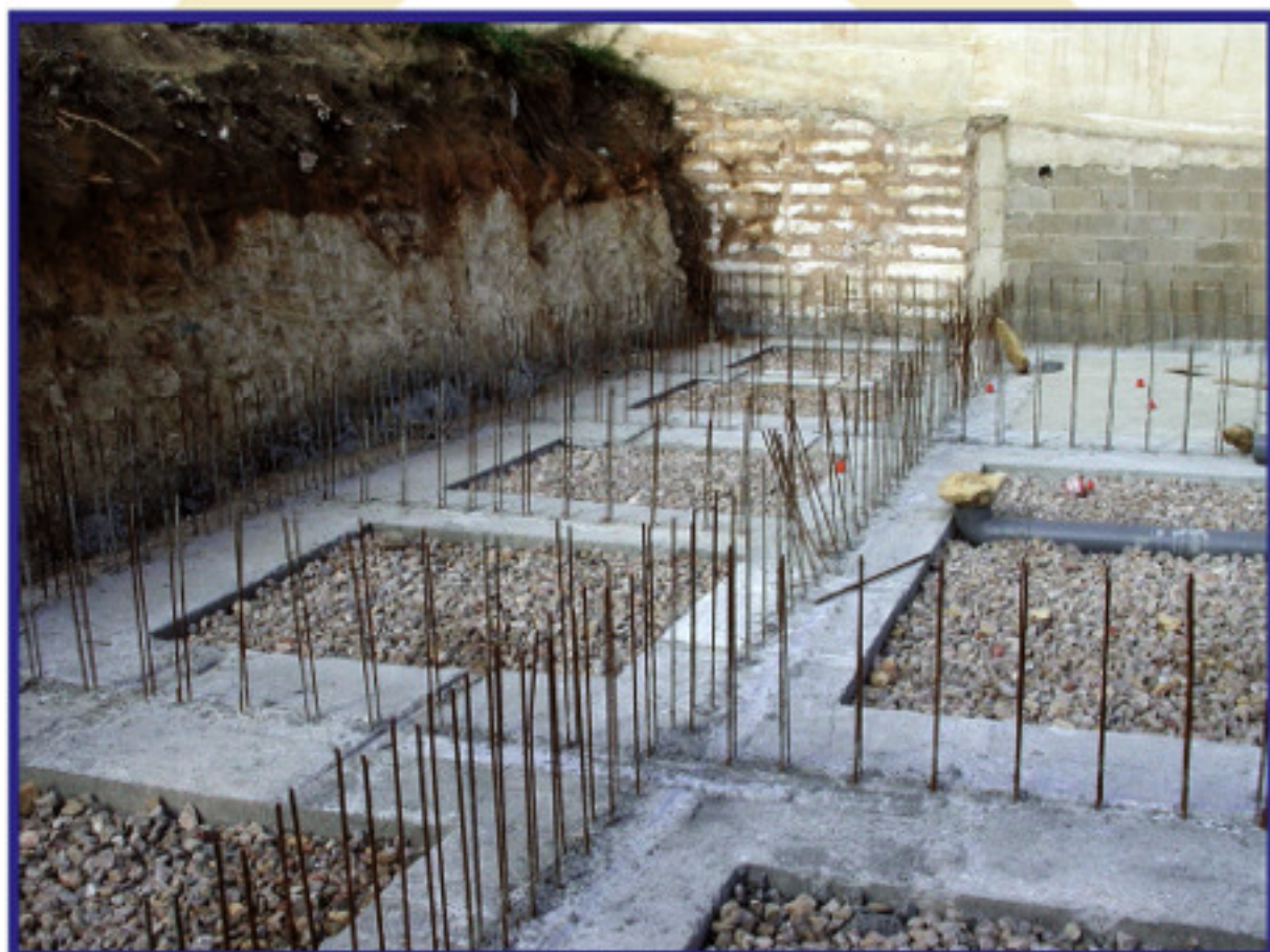
DETALLE DE CIMENTACION SEGUN CALCULO
